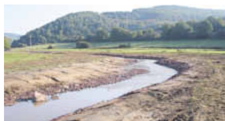
So sah das neue Flussbett der Leuk 2008 nach Ende der Bauarbeiten aus.
