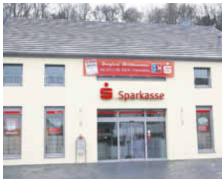
Die neue Sparkassengeschäftsstelle in Trierweiler.
