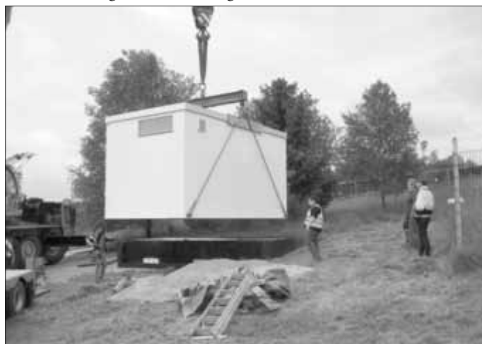
Anlieferung der Wechselrichterstation
