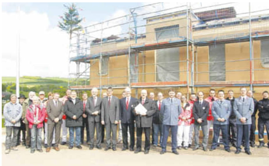
Vertreter aus Politik, Verwaltungen, Rettungsorganisationen und die beteiligten Planer und Baufirmen vor dem Rohbau der neuen Rettungswache in Pluwig.
