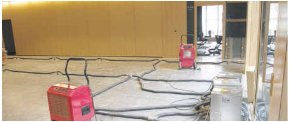
Trocknungsmaschinen sind im Neubau des Gymnasiums in Schweich im Einsatz. Die Schüler werden in der Sanierungsphase in mobilen Klassen unterrichtet.
