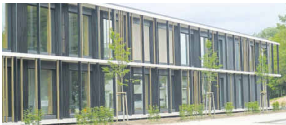
Die Sanierung des Neubaus ist beendet, so dass die Räume wieder freigegeben werden.
