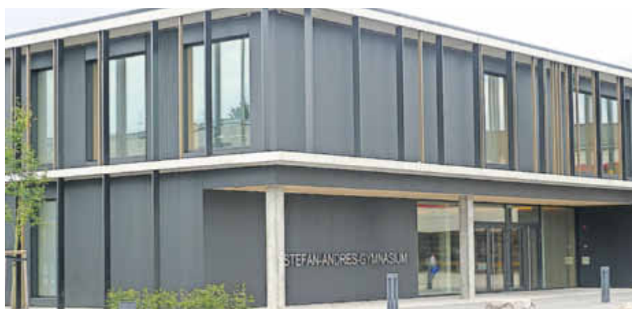
Der Neubau des Gymnasiums steht wieder für den Unterricht zur Verfügung.
