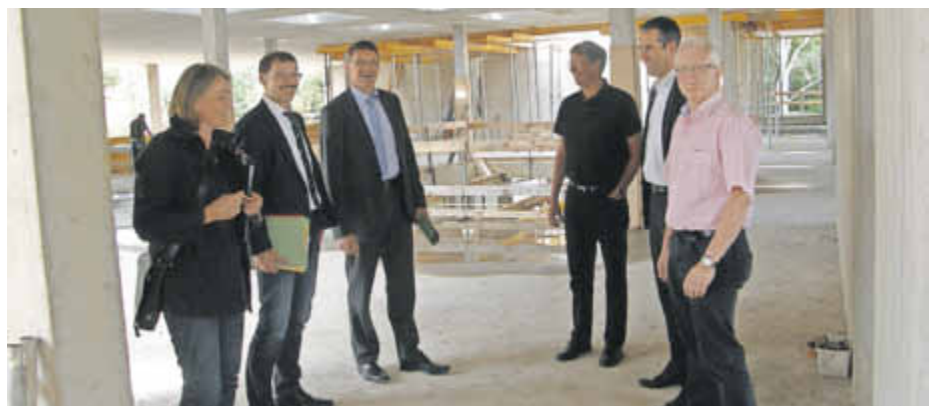
Besichtigten die Baustelle: Jürgen Nisius, Leiter der Realschule plus, Rolf Rauland, Geschäftsbereichsleiter der Kreisverwaltung, Raimund Mirz, Schulleiter des Gymnasiums, Landrat Günther Schartz sowie Norbert Etringer und Ulrike Stein von der Abteilung Gebäudemanagement und Schulen der Kreisverwaltung (v.r.)
