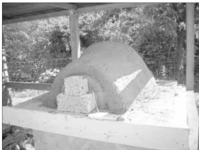
Der Lehmofen ist fertig und musste nun vier Wochen austrocknen
