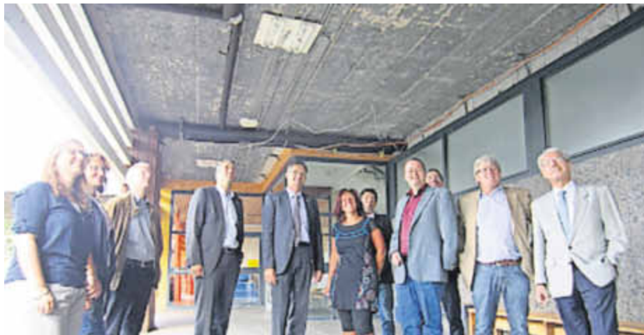
Die Vertreter des Kreises und der Verbandsgemeinde stellen im Beisein der Schulleitung die Planungen für die Sanierung und Modernisierung der Ruwertalschule vor.
