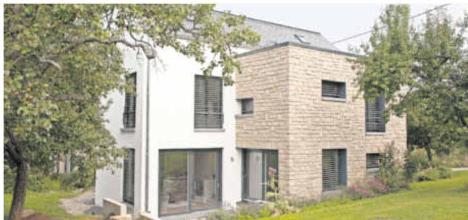
Schont das Klima: Der Udefanger Sandstein hatte es nicht weit bis zur Baustelle.
