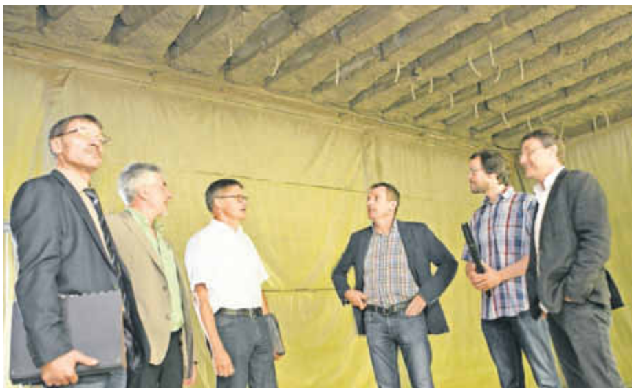
Bauleiter Jörg Fuhr (r.) erläutert Landrat Günther Scharzt, Schulleiter Heinz Oberbillig (3. und 2.v.l.) und den weiteren Beteiligten die Arbeiten an der Stahlbetondecke im Altbau.
