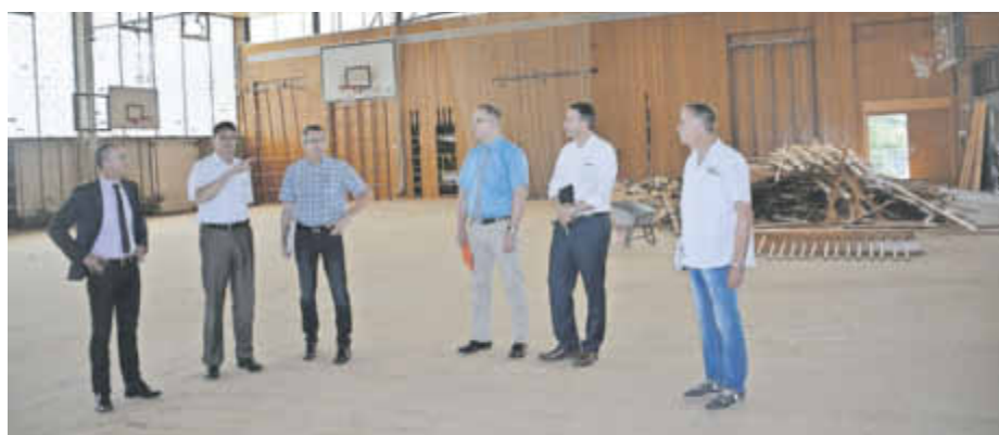
Im Schulzentrum Konz läuft seit Beginn der Ferien die Sanierung der Saar-Mosel-Halle.
