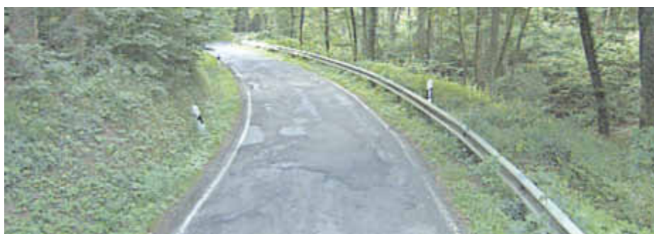
Die Kreisstraße 19 zwischen Hofweiler und Kordel befindet sich in einem schlechten Zustand und soll nun saniert werden.
