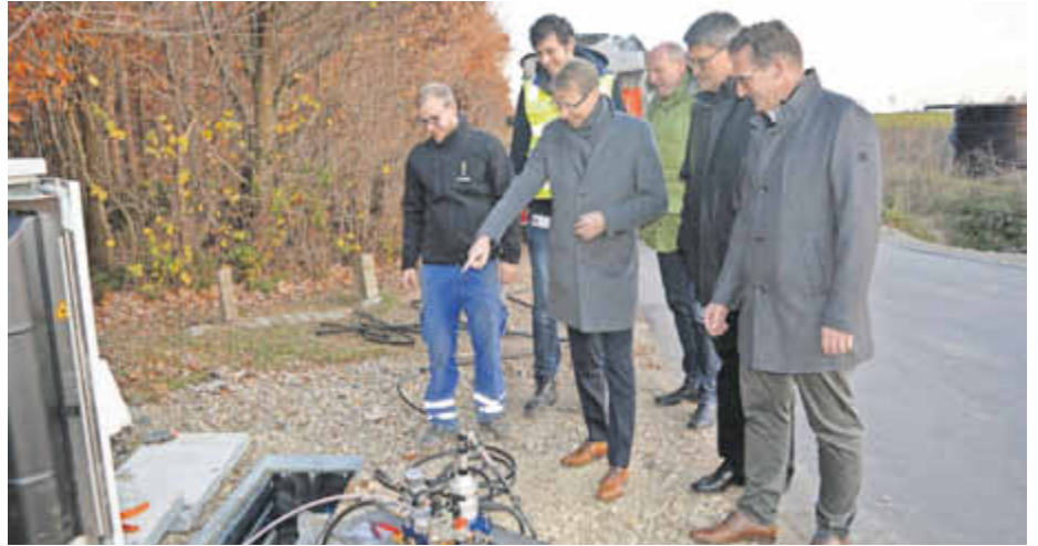
Gemeinsam mit Vertretern vom Energieunternehmen innogy besichtigte Landrat Günther Schartz (2.v.r.) einen Kabelgraben und einen Glasverteilerschrank zum Ausbau des schnellen Internets in der Ortsgemeinde Zemmer.
