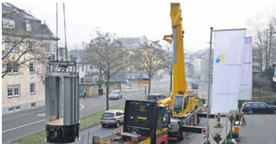
Mit einem Schwerlastkran wurde in der vergangenen Woche ein neuer Fahrstuhl in das Kreisgebäude in Trier eingeführt. Nach der Endmontage soll der gläserne, kreisrunde Aufzug im Auge des Treppenaufgangs sämtliche Etagen und Halbetagen des Verwaltungsgebäudes am Willy-Brandt-Platz auch barrierefrei zugänglich machen.
