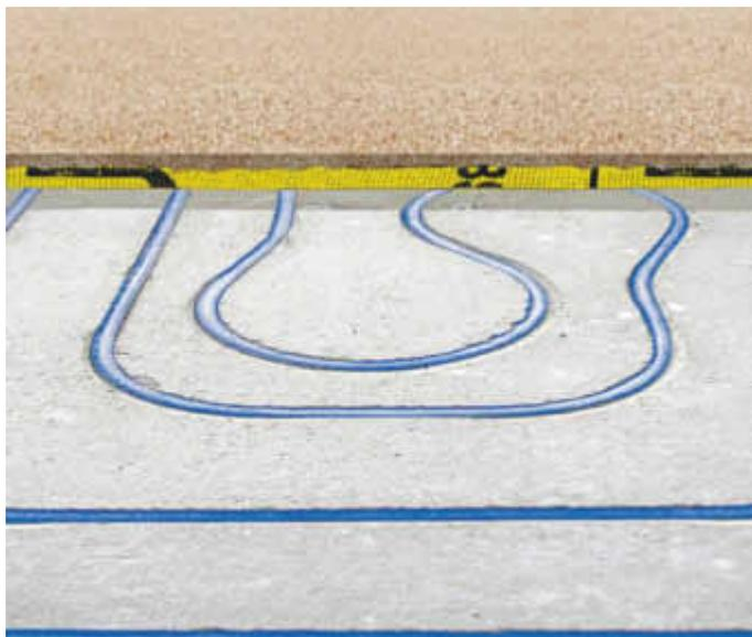
Aufgrund rissüberbrückender und wärmeverteilernder Entkopplungsmatte ist eine moderne Bodenplatte mit allen fußbodengeeigneten Bodenbelägen kompatibel. Sie kann also unter Stein, Fliesen, Parkett, Laminat oder auch Dielen verlegt werden.
