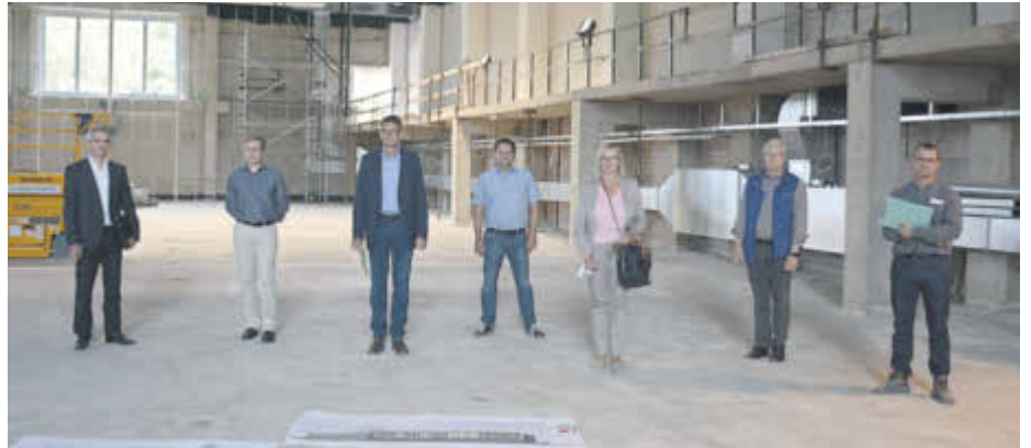
Landrat Günther Schartz (3.v.l.) überzeugte sich vor Ort von dem Baufortschritt der Sporthalle am Schulzentrum Schweich.
