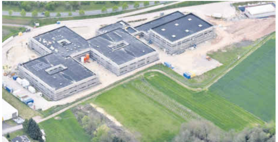
Trotz einiger Schwierigkeiten ist deutlich sichtbar: Der Gebäudekomplex für die beiden Schulen nimmt Formen an.
