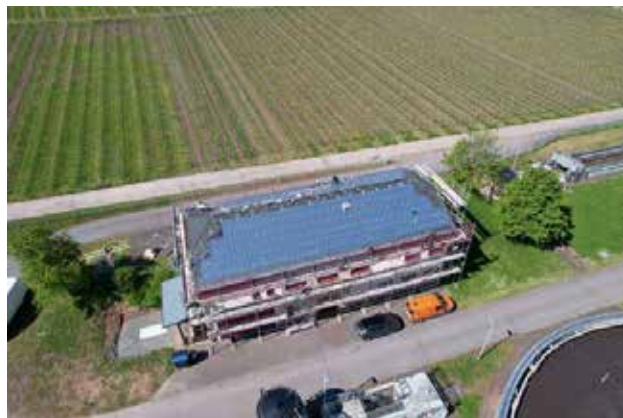
Kläranlage Leiwen Installationsarbeiten Photovoltaikanlage
