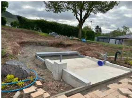
Freibad Schweich Neubau Durchschreitebecken mit Duschen
