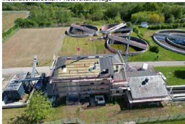
Kläranlage Leiwen Installationsarbeiten Photovoltaikanlage
