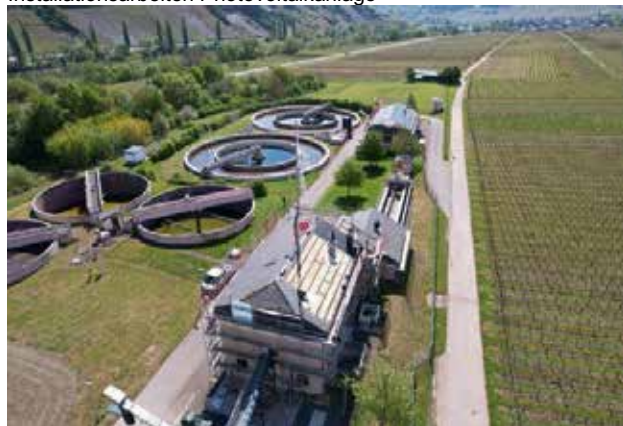
Kläranlage Leiwen Installationsarbeiten Photovoltaikanlage
