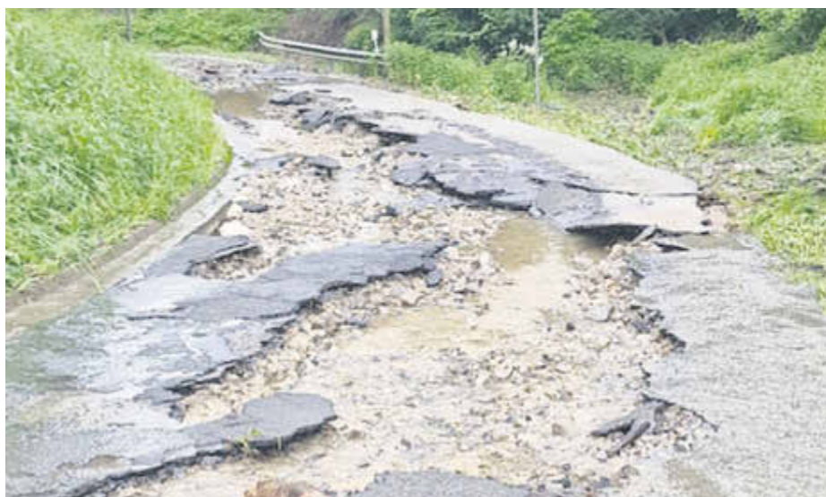
Diese Schäden an der Kreisstraße 7 bei Udelfangen sind durch das Unwetter an Pfingsten entstanden.
