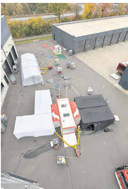
Der AB Dekon-V ist in einen schwarzen Bereich (vor der Dekontamination) und einen weißen Bereich (nach der Dekontamination) aufgeteilt.
