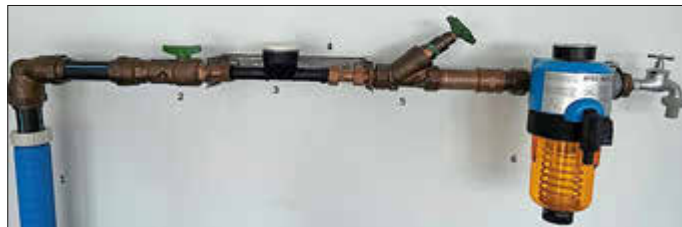
Skizze (Foto mit Beschriftung/Erläuterung) Wasserzähleranlage
