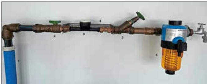
**Skizze (Foto mit Beschriftung/Erläuterung) Wasserzähleranlage**
