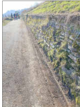
Freigelegte Drainage am Wingert
