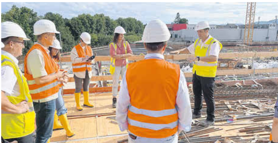
Das Planungsteam präsentierte den Stand der Bauarbeiten bei einem Rundgang.
