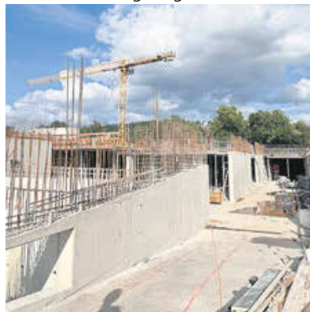
Die Betonarbeiten liegen im Zeitplan.
