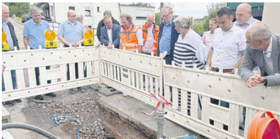
Die Mitglieder des Bauausschusses schauten sich unter anderem die Arbeiten an der Kreisstraße 47 in Zerf an.
