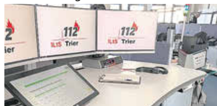
Ein Blick in die Leitstelle
