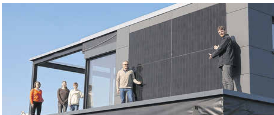
Familie Gutwin und Paul Lippl (r.) vom Klimaschutzmanagement des Kreises präsentieren das bezuschusste Balkonkraftwerk. Die vier schwarzen Module sind Teil der Fassade.
