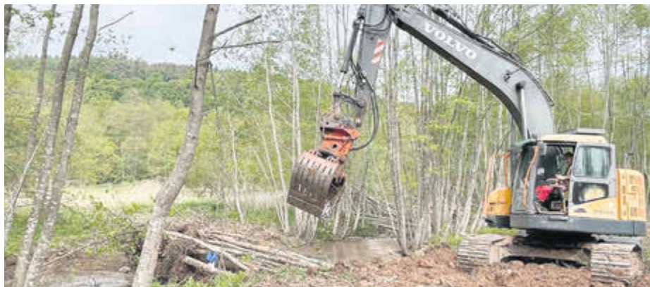
Ein Bagger baut Strömungslenker in das Gewässer ein, die der Natur viele Jahrzehnte Arbeit abnehmen.
